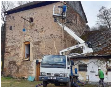
Instalace elektrického ohrazení. PJ Installation of an electric fence
