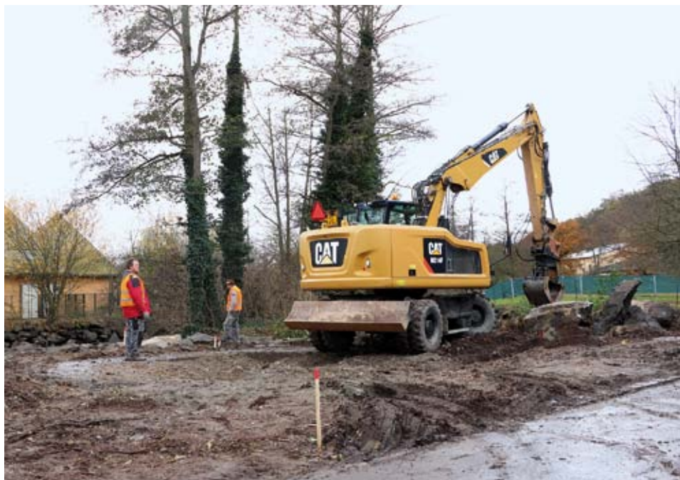
Zahájení výstavby pavilonu gueréz angolských. KM Construction begins on the Angolan Colobus pavilion
