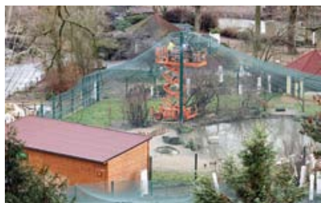
Oprava voliéry pro plameňáky. KM Rebuilding of the flamingo aviary
