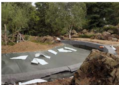
Červenec 2023. KM July 2023
