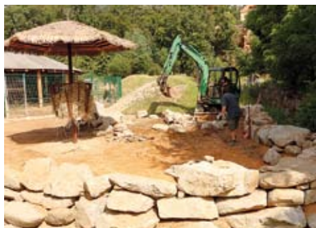
Úprava vodního příkopu u vyhlídky velbloudů. KM Modification of the water ditch at the camels view point
