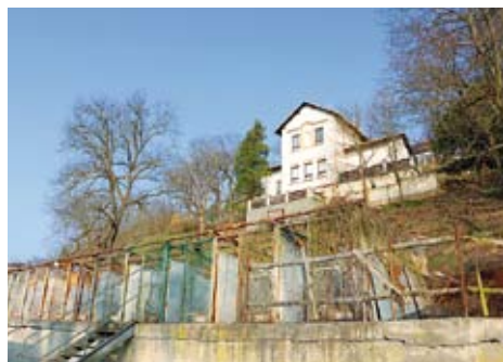
Ústřední budova a kotce v bývalém psinci. KM The main building and former dog kennels
